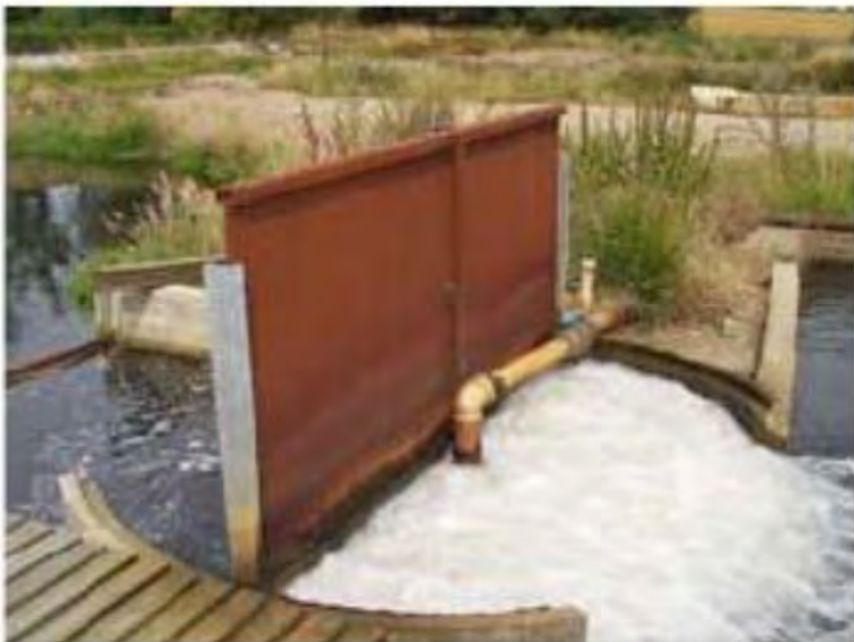
Иллюстрация Система с аэрационным колодцем.
