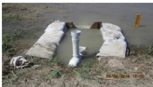
Күріш атыздарына суды беру мен есепке алуды қамтамасыздайтын құрылғы жұмысы
